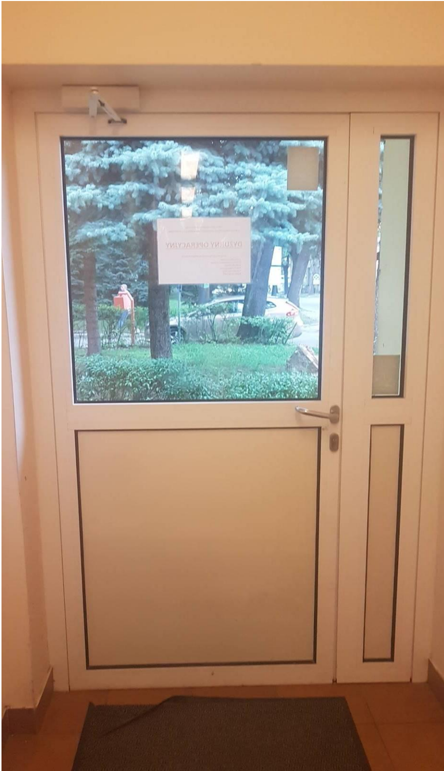
Istniejące drzwi przeznaczone do wymiany. Widok od strony wewnętrznej.
